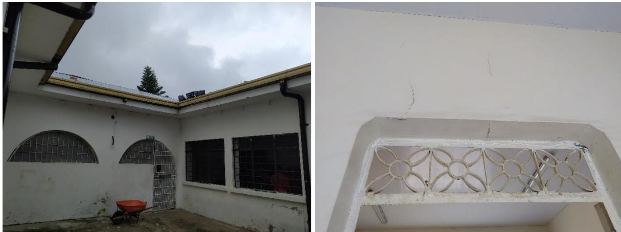
La cocina se encuentra en buen estado, el único inconveniente que se percibe son algunas líneas de grietas en la pintura y los muros que se observan debido a que se intuye que pueda ser por filtraciones de agua de la cubierta.
