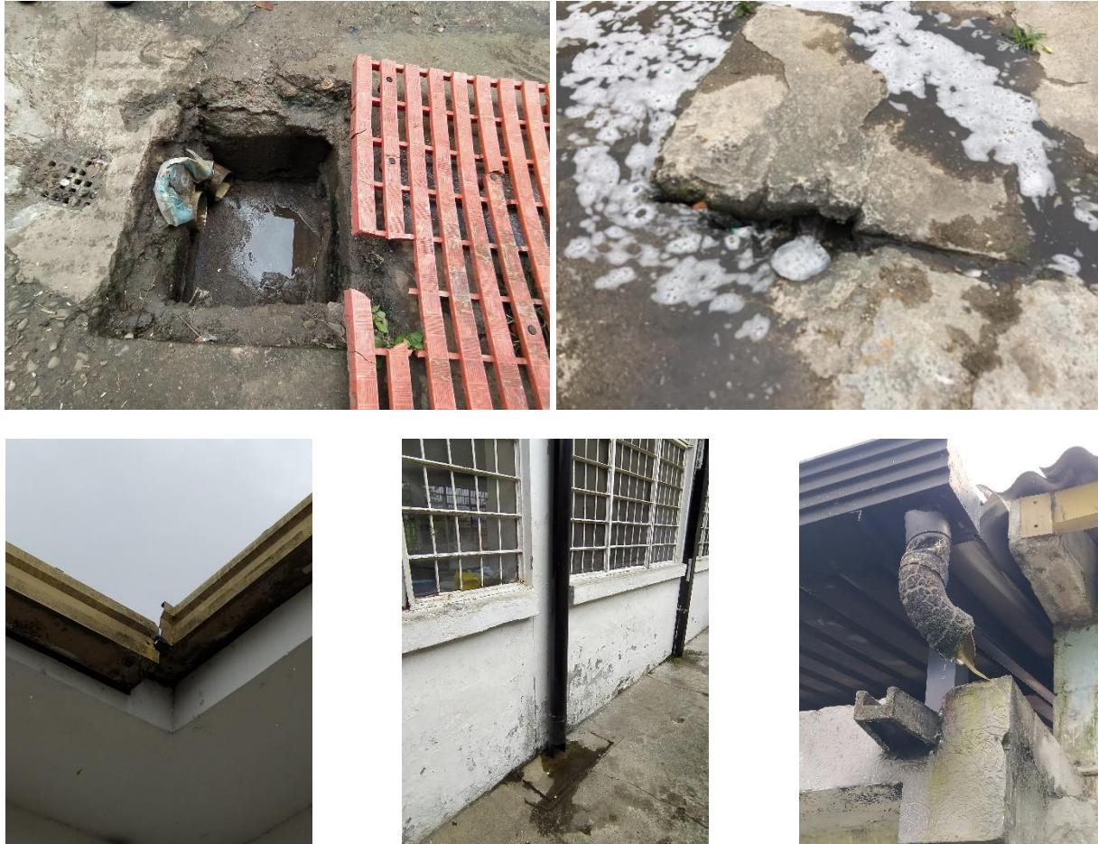
Las canales y bajantes de agua lluvia se encuentran deterioradas o dañadas, además algunas bajantes vierten el agua directamente en los pisos lo cual genera un deterioro acelerado de los mismos. El sistema de alcantarillado en varias ocasiones ha sido insuficiente, situación que ha generado inundaciones en varios lugares del CAE.
