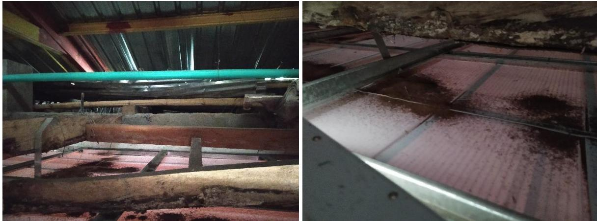
Una parte de la estructura de la cubierta del gimnasio de Hapkido está compuesta en madera, la cual presenta deterioro por el paso del tiempo, igualmente esta problemática está generando daños en el cielo raso y los puntos lumínicos debido a que también el material de las tejas al ser tan liviano, y al subirse los jóvenes a los tejados causan daños en las tejas generando filtraciones de agua que deterioran la estructura y los cielos rasos.
