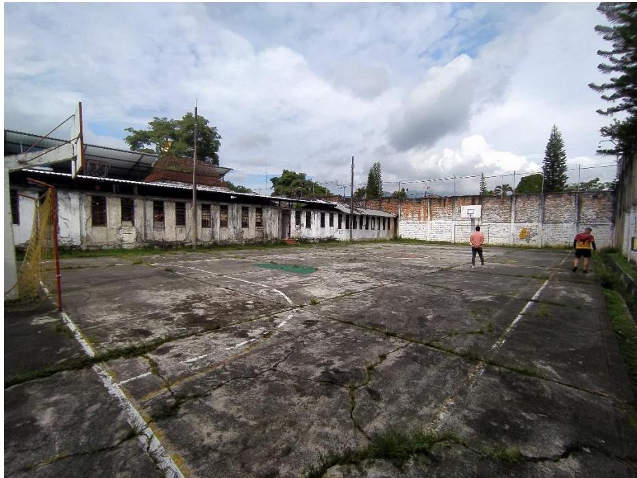
La placa de la cancha se encuentra muy deteriorada, con múltiples grietas, con la pintura de demarcación también deteriorada, así como los arcos y tableros.
