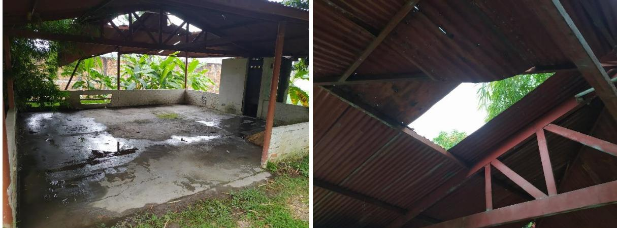
La estructura de la cubierta del kiosco también se encuentra averiada debido a la corrosión que se puede observar lo cual a futuro podría presentar un accidente al fallar la misma estructura.
