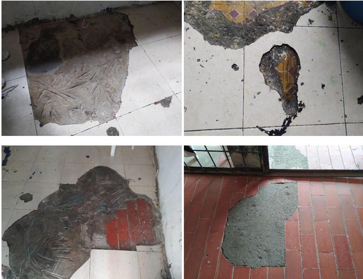
Se observan fracturas en las cerámicas de los pisos, daños ocasionados por los jóvenes en motines, se evidencia en muchos lugares piezas faltantes de las mismas y en muchos otras cubiertas de pintura.
