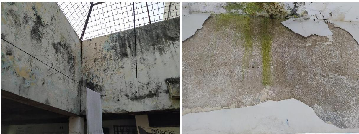
La humedad, los incendios al interior y los grafitis han causado el deterioro del estuco y la pintura de los distintos muros y placas, dejando expuestos los muros de la edificación y así haciendo más fácil para los jóvenes picar los mismos para hacer caletas o agujeros.
